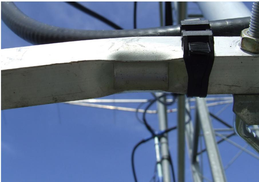
La jambe de force est ensuite assemblée sur le boom avec des plaques de Dibond, matériau sandwich composé d'aluminium et de polyéthylène. Facile à couper, rigide, léger, on en trouve des chutes chez les professionnels de la chaîne graphique, sérigraphes etc...
